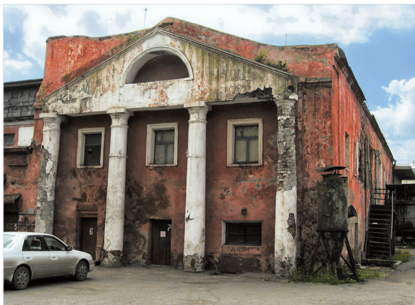
Правый портик фасада первой плавильной фабрики. Фото 2007 г.
