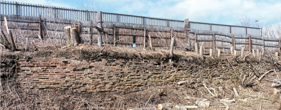
Кирпичная кладка сухого откоса плотины. Фото 2016 г.
