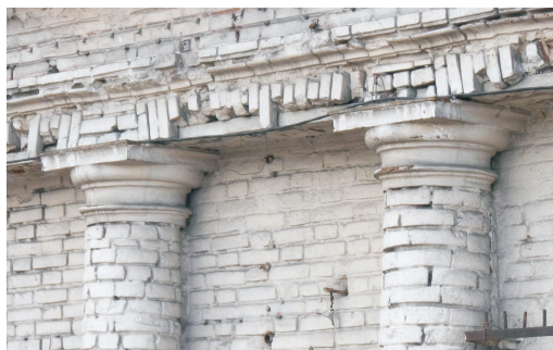
Чугунные капители кирпичных колонн второй плавильной фабрики
